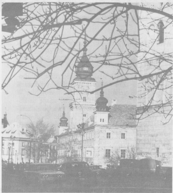
124. Zamek, widok z Krakowskiego Przedmieścia, stan po odbudowie
