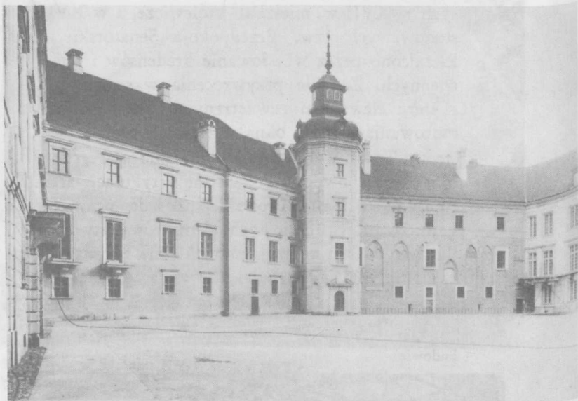
125. Dziedziniec Wielki z Wieżą Władysławowską, stan po odbudowie
