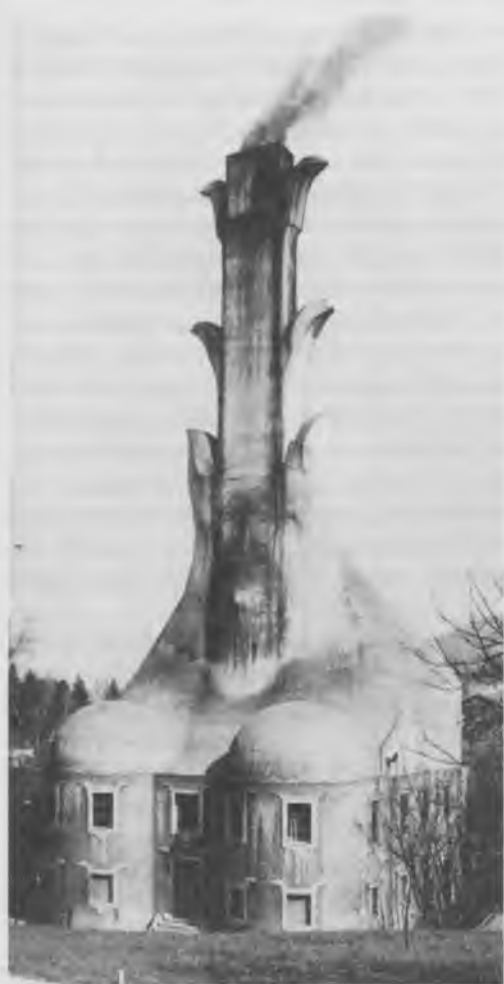
Kotłownia przy Goetheanum w Dornach.
