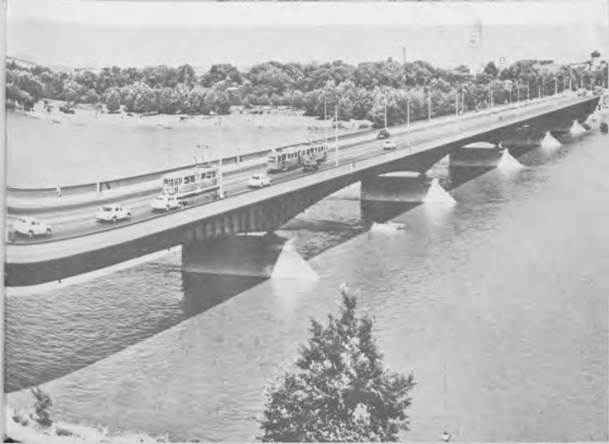
78. Most Kierbedzia — Śląsko-Dąbrowski po odbudowie w roku 1949
