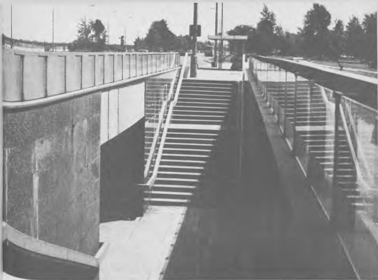
92. Wisłostrada, przejście podziemne na Podzamczu z roku 1974
