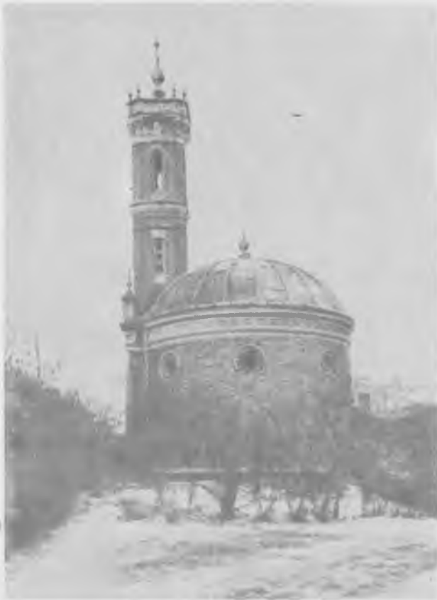
29. Zbiornik wody i wieża ciśnienia wodociągu A. Gro-towskiego na Pradze (nie istniejące)
