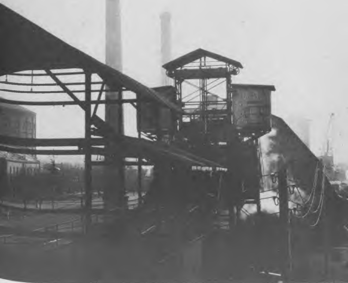
49. Ogólny widok gazowni na Czystem (Wola) przy ulicy Kasprzaka 25
