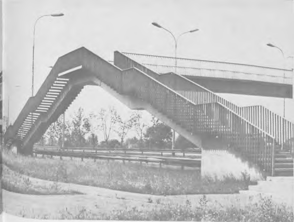
95. Kładka na Wisłostradzie na Bielanych z roku 1975
