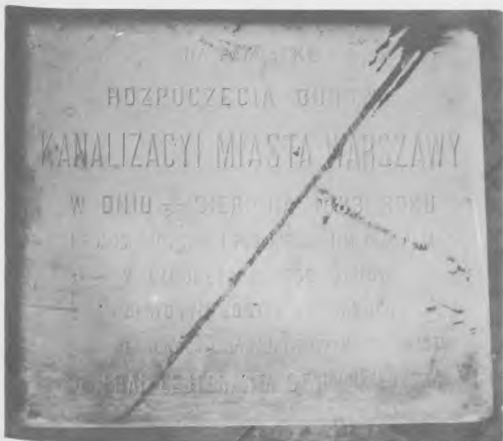
39. Marmurowa tablica na stacji filtrów na Koszykach upamiętniająca rozpoczęcie budowy kanalizacji Lindleyowskiej 20 sierpnia 1883 roku
