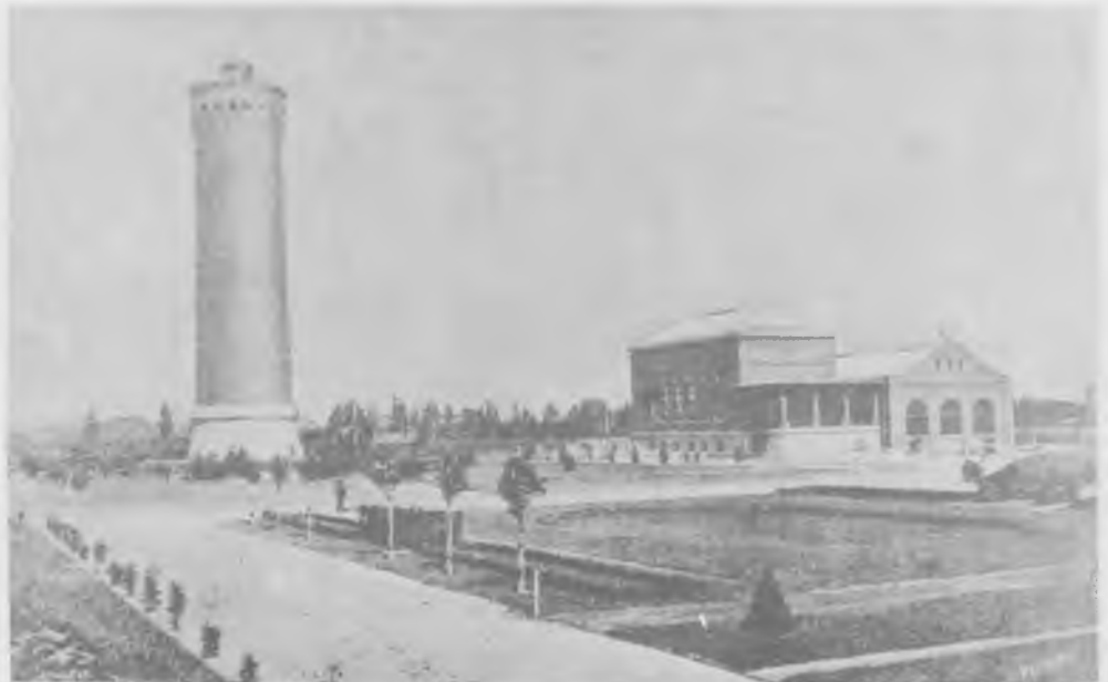
30. Wieża ciśnienia i stacja pomp filtrów wodociągów Lindleyowskich Na Koszykach. Fotografia z roku 1908
