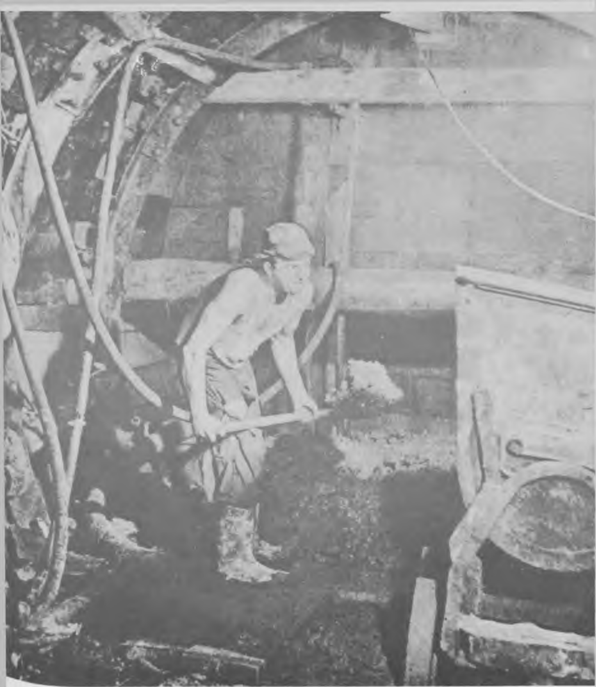
53. Budowa 900-metrowego tunelu pod dnem Wisły dla przewodów ciepłej wody z Elektrociepłowni „Żerań” na Żoliborz
