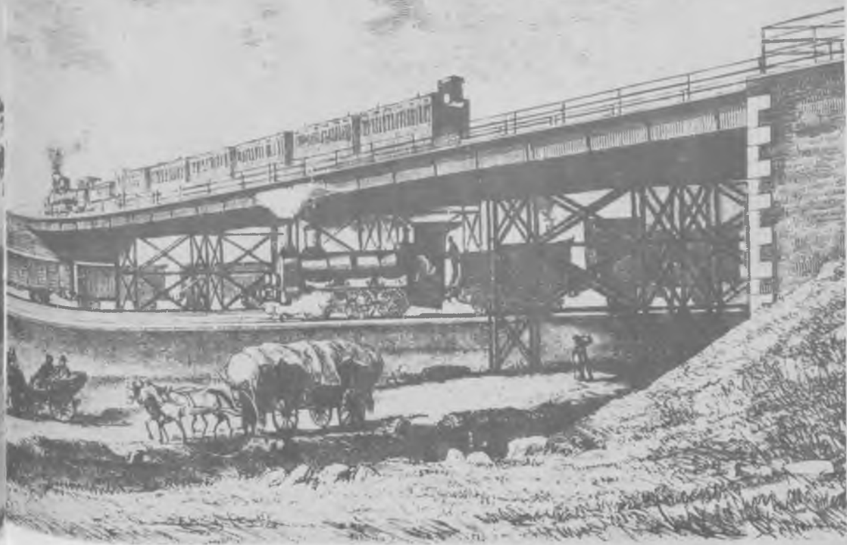
90. Wiadukt z roku 1875, przeprowadzający linię kolejową do Mławy ponad linią kolejową do Białegostoku oraz linią obwodową i obecną ulicą Świerczewskiego i Radzywińską
