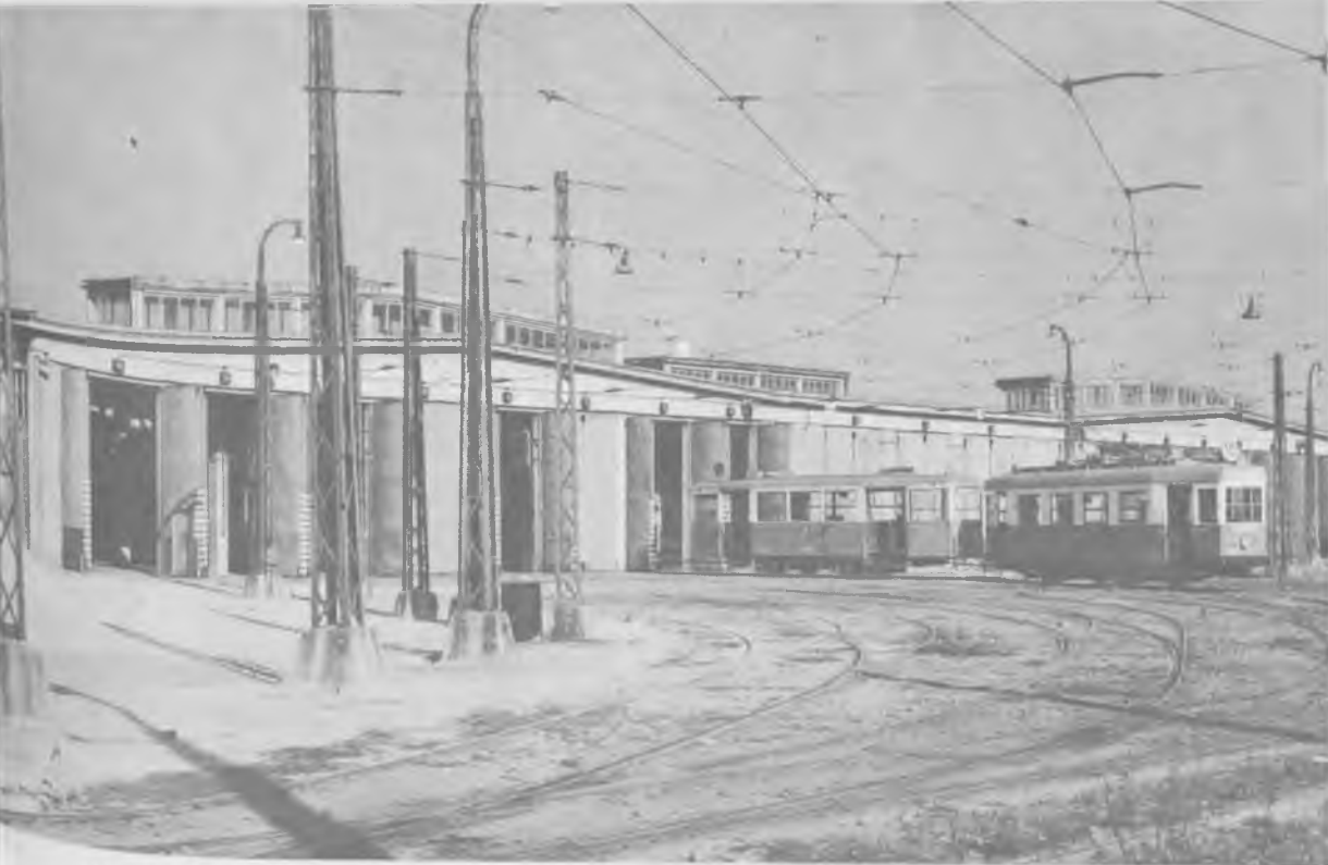
101. Zajeżdźnia tramwajowa przy ulicy Woronicza
