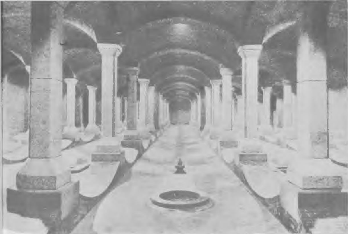
31. Filtry powolne wodociągów Lindleyowskich Na Koszykach. Fotografia z roku 1936
