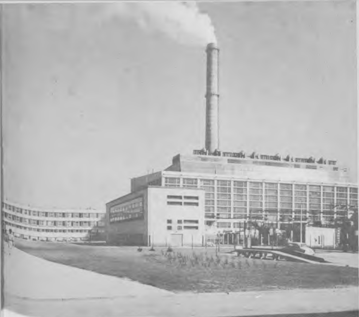
55. Elektrociepłownia na Siekierkach od roku 1961
