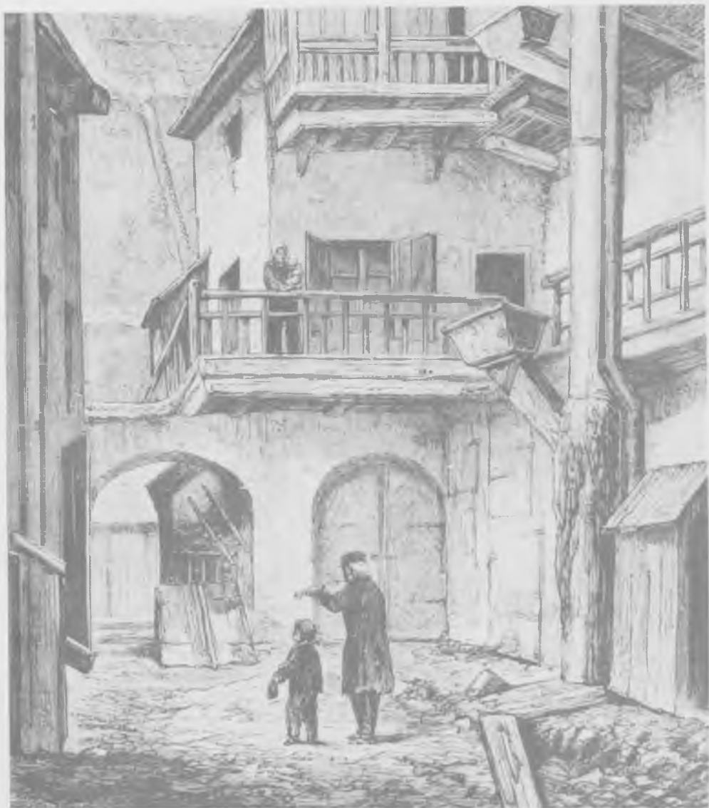
40. Drewniane zlewy i przewody kanalizacyjne stosowane przed wprowadzeniem kanalizacji Lindleyowskiej. Podwórkó domu przy ulicy Podwale 523
