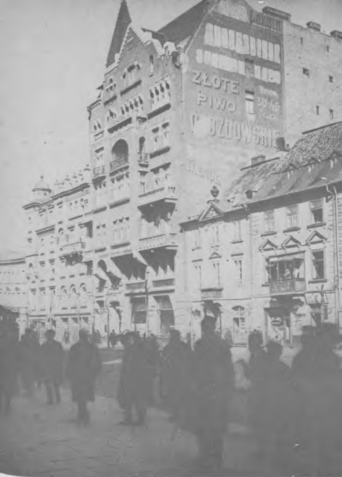
58. Łaźnia Centralna „Pod Messalką” przy Krakowskim Przedmieściu w podziemiach budynku wzniesionego w roku 1907 wg projektu J. Dzierżanowskiego, po wojnie przebudowanego i obniżonego
